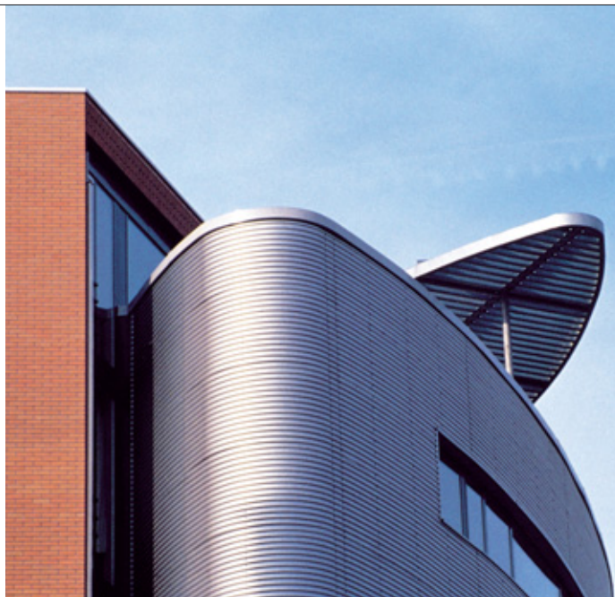
Remo-Invest Kantoorgebouw, Brussel Aluform golfprofielplaat 18/76
