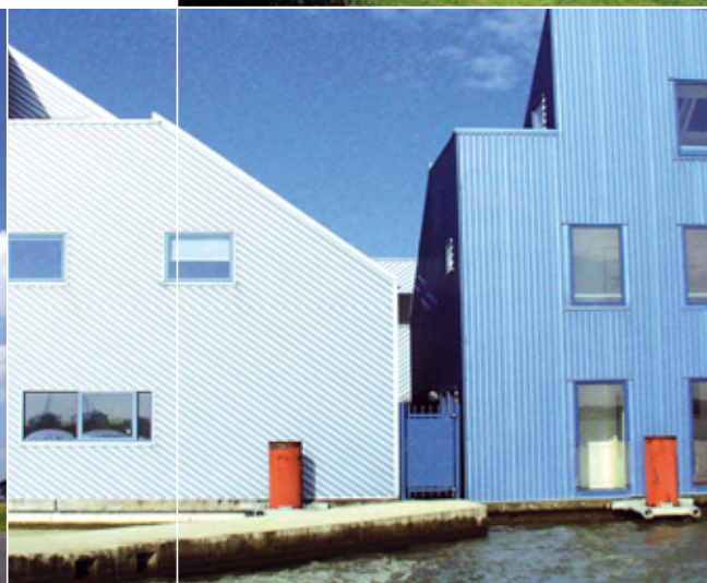
Waterwoningen, IJburg Aluform damwandprofielplaat 29/124
